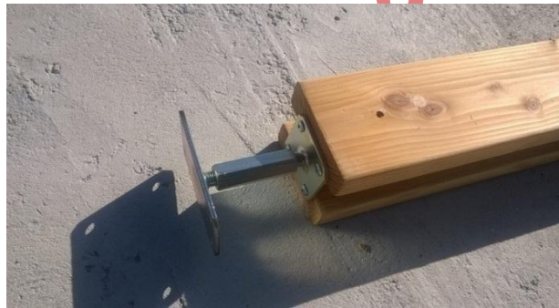
Fixations pied de poteau fixe (pied réglable en option) avec 4 vis 8/80
